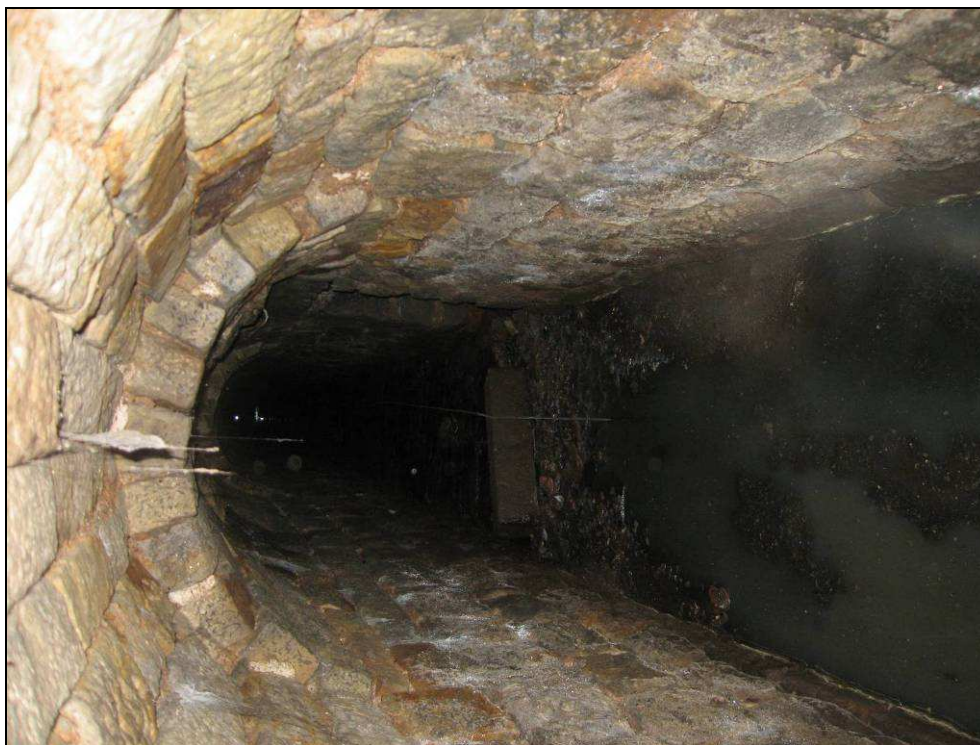
Obr. č. 9 - Pohled do propustku. Nosná konstrukce je klenbová z kamenného zdiva. Spodní stavba je z kamenného zdiva. Kamenné zdivo je zachovalé, kameny jsou pískovce, většinou pevné, avšak proměnlivé pevnosti. Pojivo je silně až zcela degradované, avšak ve spárách dosud drží.
