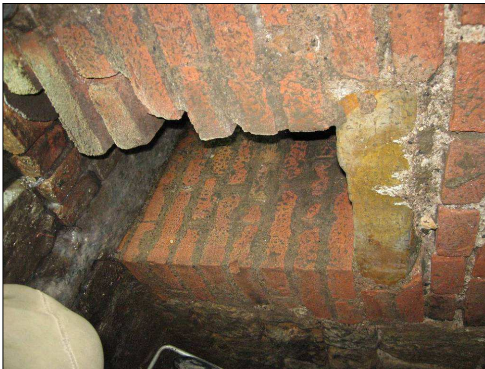
Obr. č. 14 - přítok do propustku ve směru od České Skalice. Štola malého profilu, kde SS je z cihelného zachovalého zdiva z pevných cihel a NK je z kamenných desek pevného pískovce. Spárování a vnitřní malta je na nároží vypadaná.
