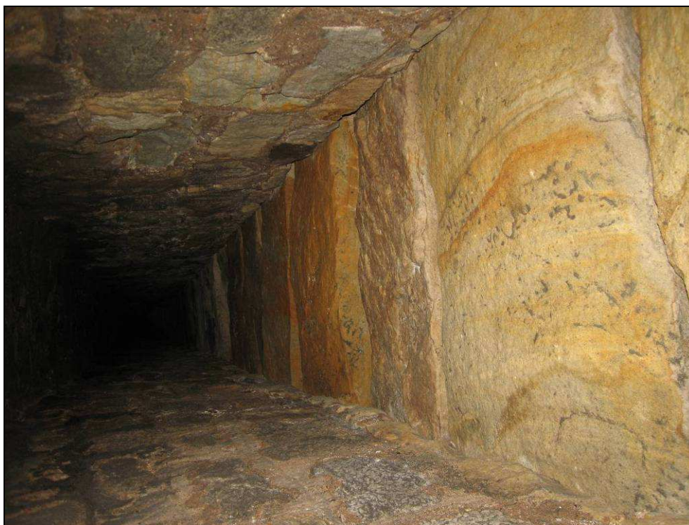
Obr. č. 11 - pohled do přítoku ve směru od HK od výtopny pod šachtou u kolejí. Detailní pohled na kamenné desky NK, které jsou z pevného pískovce.
