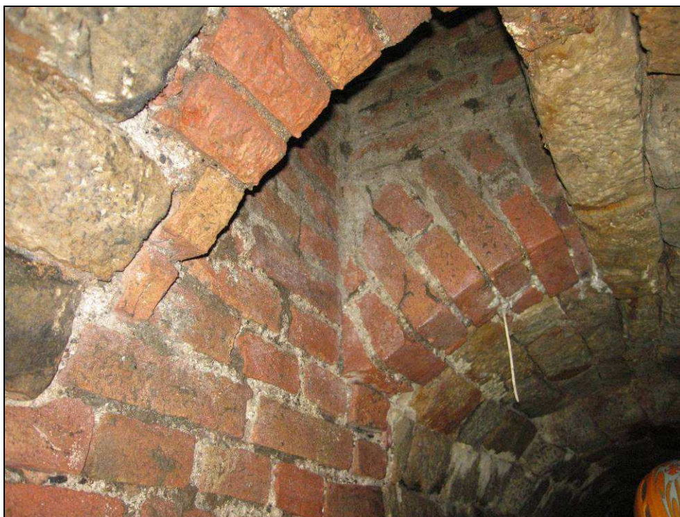
Obr. č. 17 - původní, dnes shora uzavřená šachta v místě přítoku od České Skalice. Šachta malého profilu, její stěny jsou z cihelného zdiva, které je na pohled zachovalé.
