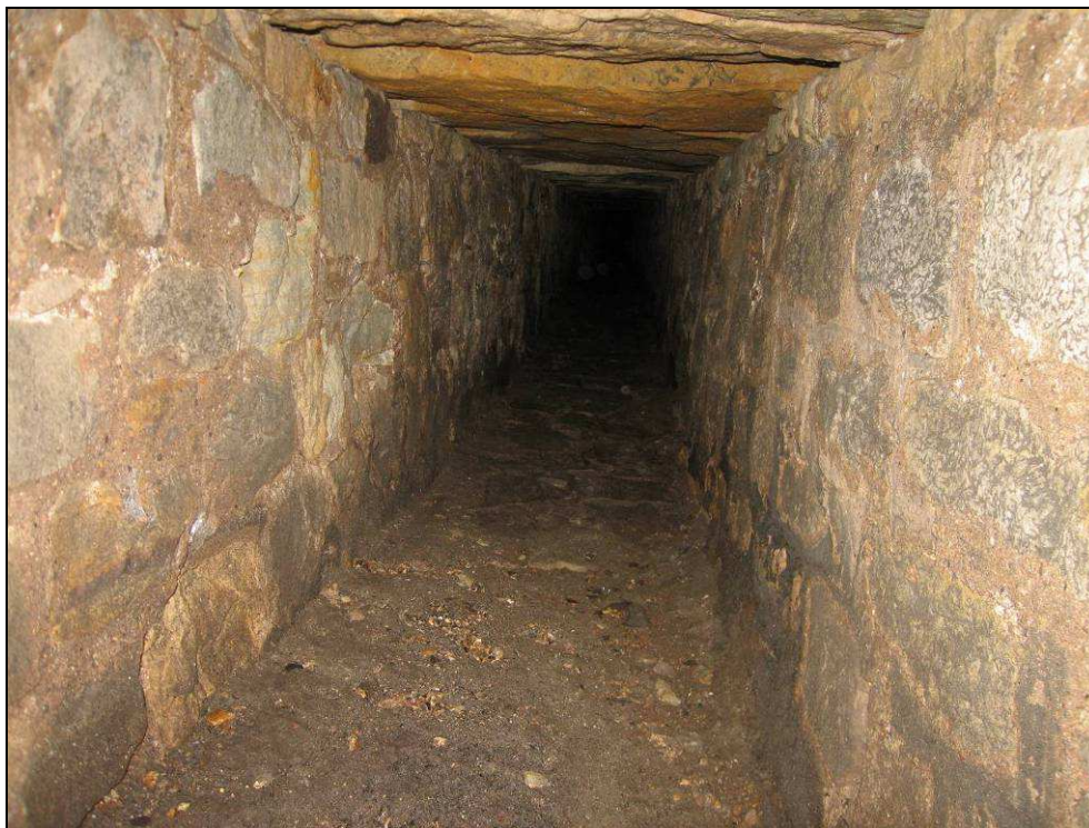
Obr. č. 10- pohled do přítoku ve směru od HK od výtopny pod šachtou u kolejí. NK je desková.
