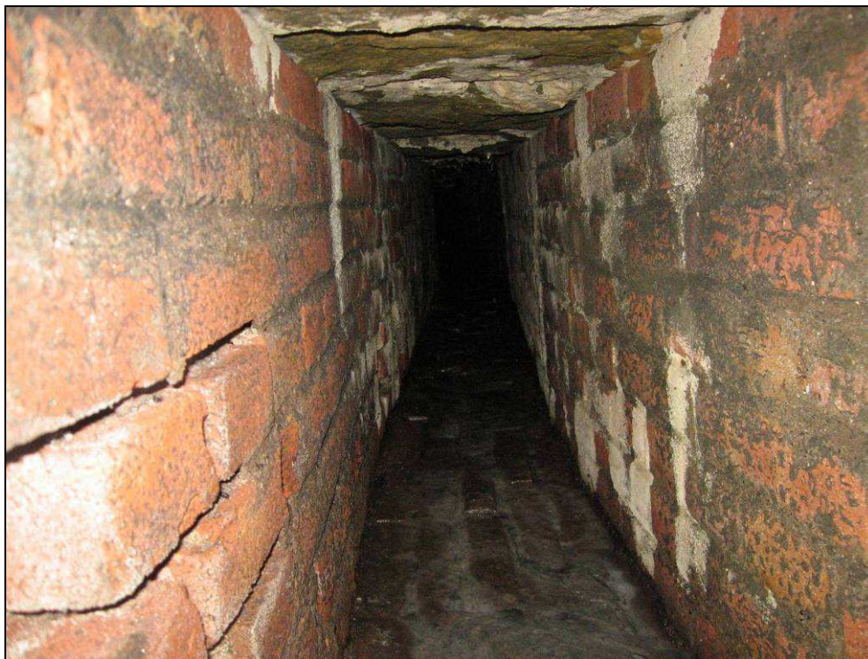
Obr. č. 15 - přítok do propustku ve směru od České Skalice. Pohled do štoly, cihelné zdivo je mokré.
