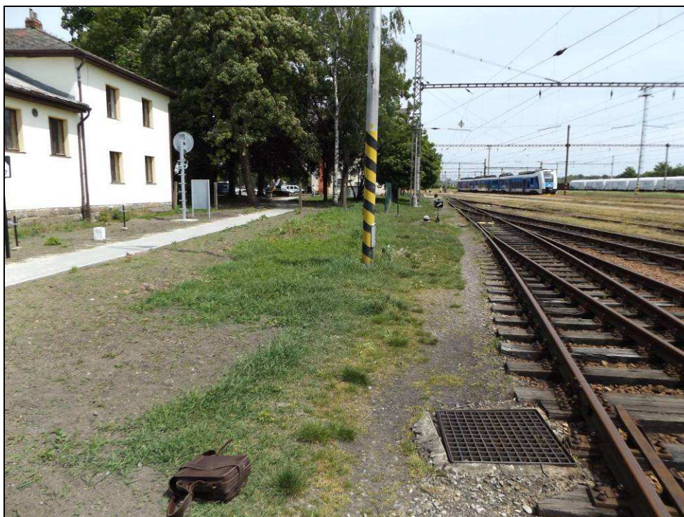
Obr. č. 6 - šachta u levého čela propustku, tzv. šachta u kolejí. Dno propustku je zde 5,10 m pod povrchem mříže poklopu.
