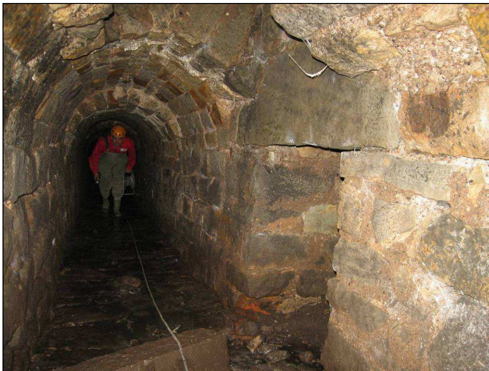
Obr. č. 8 - pohled do propustku. Shora je zaústěna do klenby šachty u kolejí, zprava je zaústěn přítok ve směru od Hradce Králové od výtopy.
