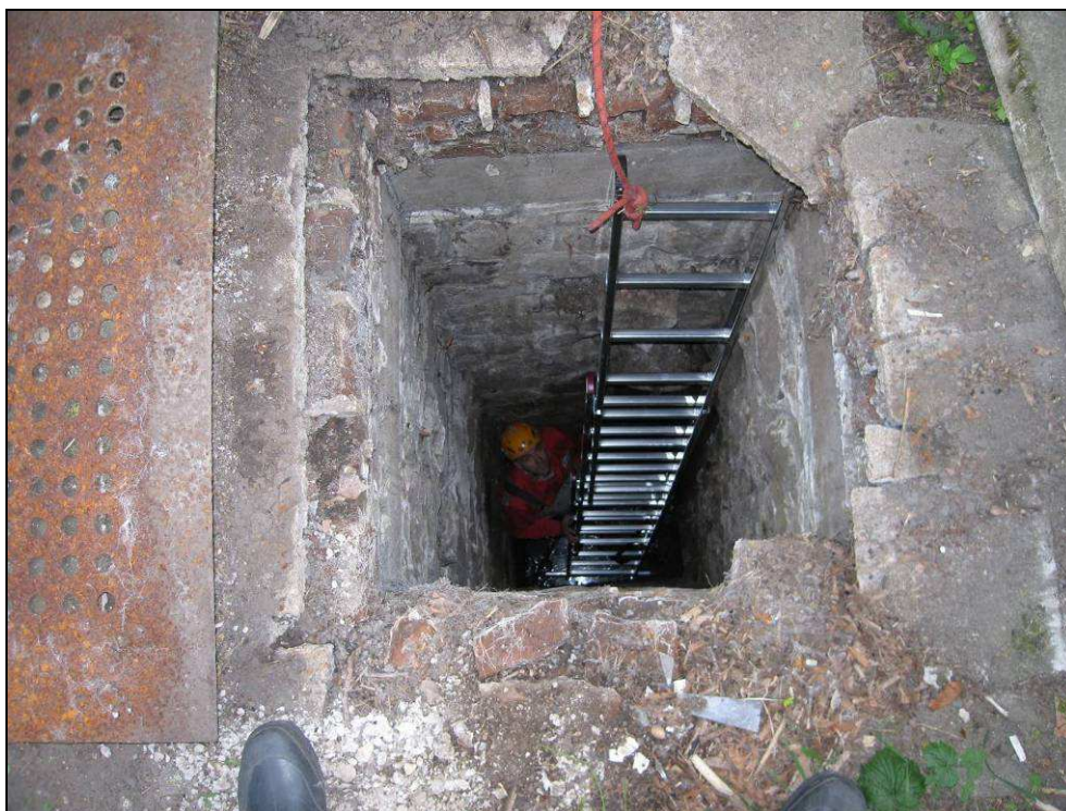
Obr. č. 5 - pohled do šachty u rohu kulturního domu. Ve stěnách šachty jsou kanalizační přípojky z kulturního domu. Zdivo této šachty je spíše zachovalé a stabilní.
