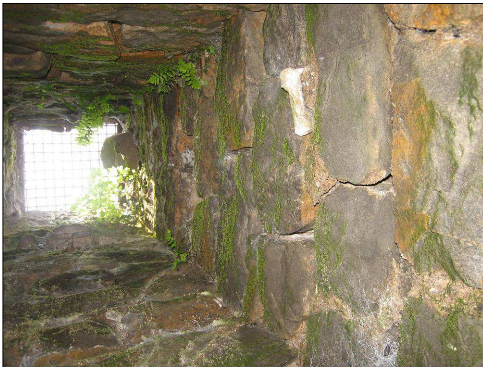
Obr. č. 12 - pohled do šachty u kolejí zdola nahoru. Zdivo stěn je porušené a spáry jsou často do hloubky vypadané.
