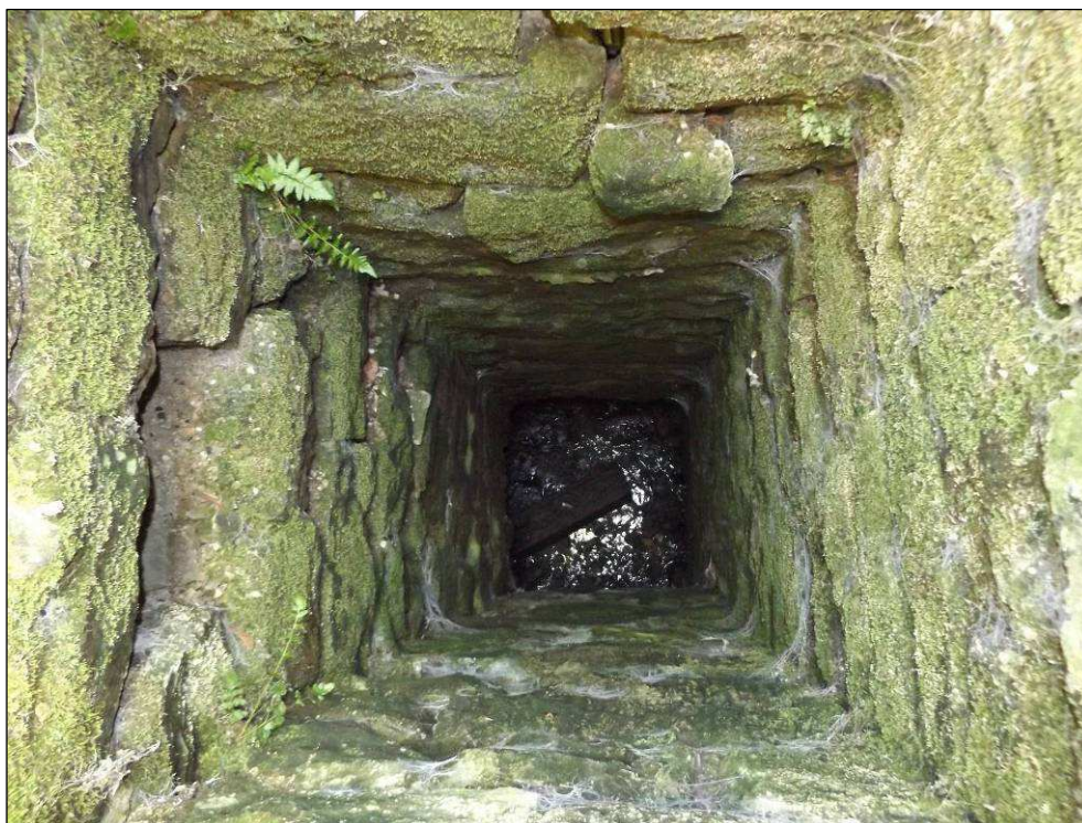
Obr. č. 7 - pohled do šachty u kolejí. Půdorysný rozměr šachty je úzký, cca 67 x 69 cm. Stěny šachty jsou z kamenného zdiva, které je porušené, pojivo je ze spár často vydrolené, kameny nejsou pevně uchycené a vypadávají.
