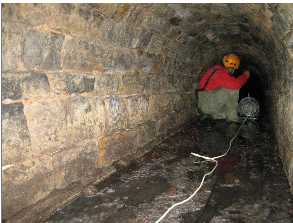
Obr. č. 19 - pohled do propustku - cca 20 m před zazděním pravého čela. Usazeniny na dně jsou zde již mocné a omezují průleznost. Stejný technický stav zdiva jako u levého čela.
